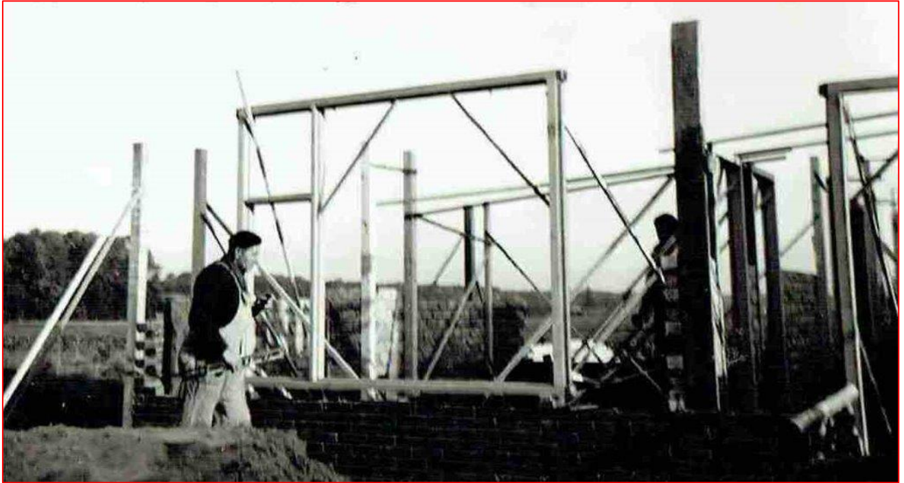
Boven; Sjef aan het werk op de bouw.
