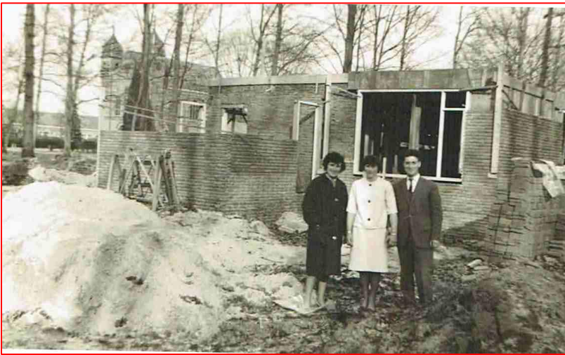
Linksboven; Ripsestraat 15 in aanbouw. Op de voorgrond staan Leny en familie en op de achtergrond zijn de oude kerk en school nog zichtbaar.
