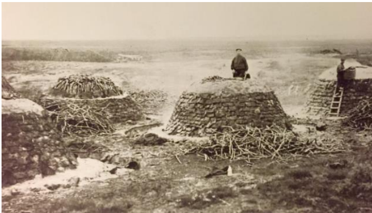
▲ Meilers in opbouw.
